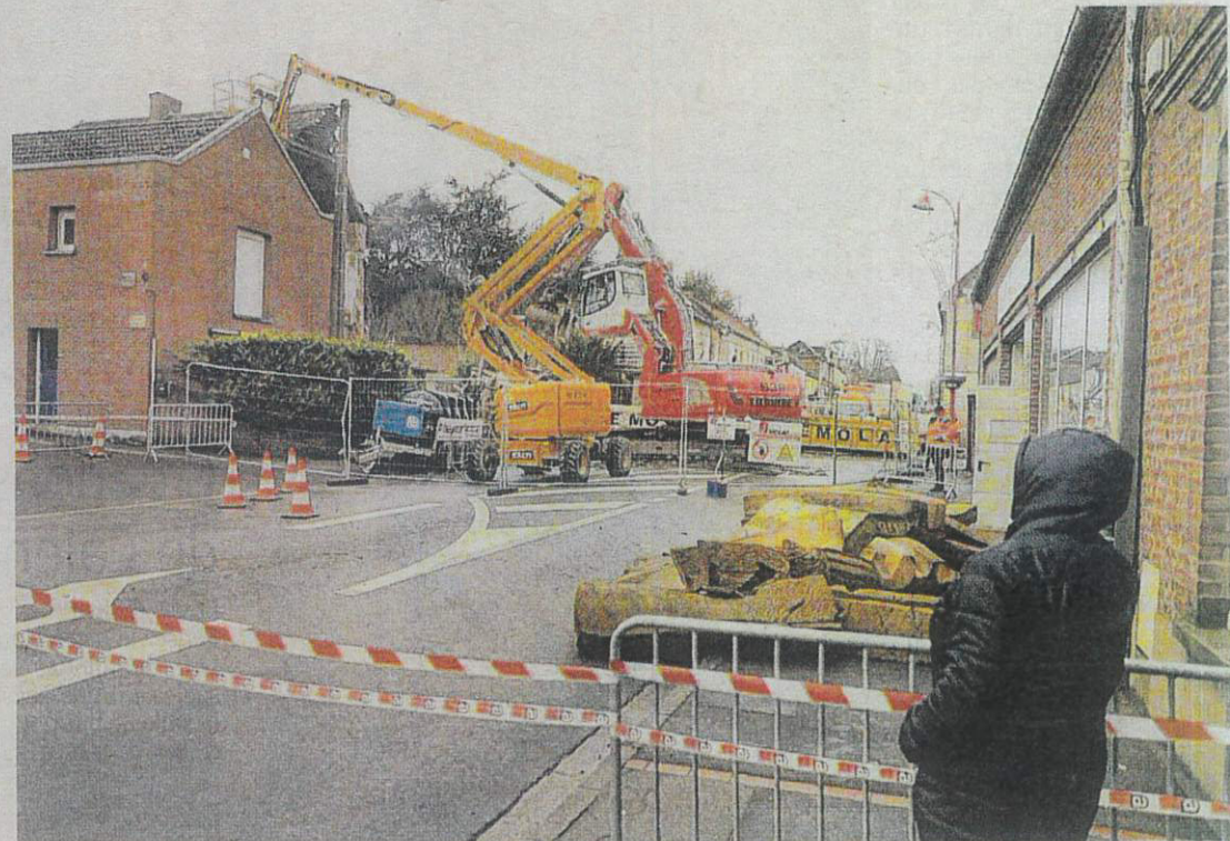
Les travaux de démolition de la maison ont débuté hier après-midi. PHOTO MATHIEU BOTTE
