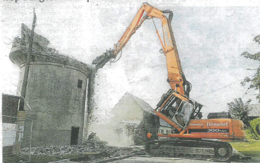
Le château d'eau n'était plus utilisé depuis les années 1960. Il a été remplacé par un équipement plus moderne.
