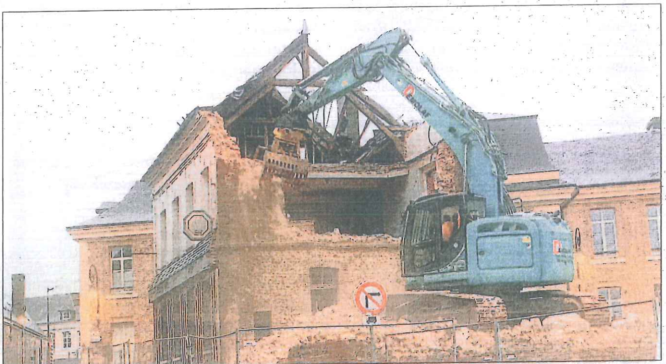
Arnaud et Sébastien, les employés de l’entreprise de démolition, ont manié la pelle avec précaution
